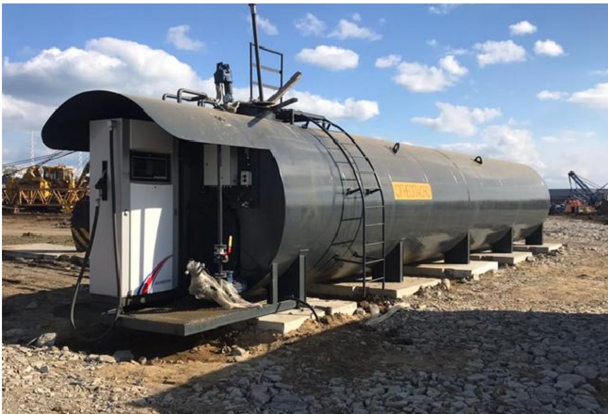
Рисунок 1 – Общий вид резервуаров
