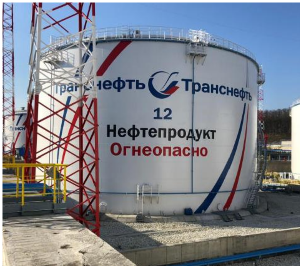
Рисунок 1 – Общий вид резервуара РВСП-30000
