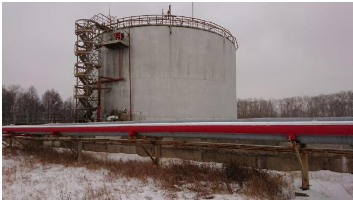
Рисунок 1 – Общий вид резервуара стального вертикального цилиндрического РВС-5000 № 4
