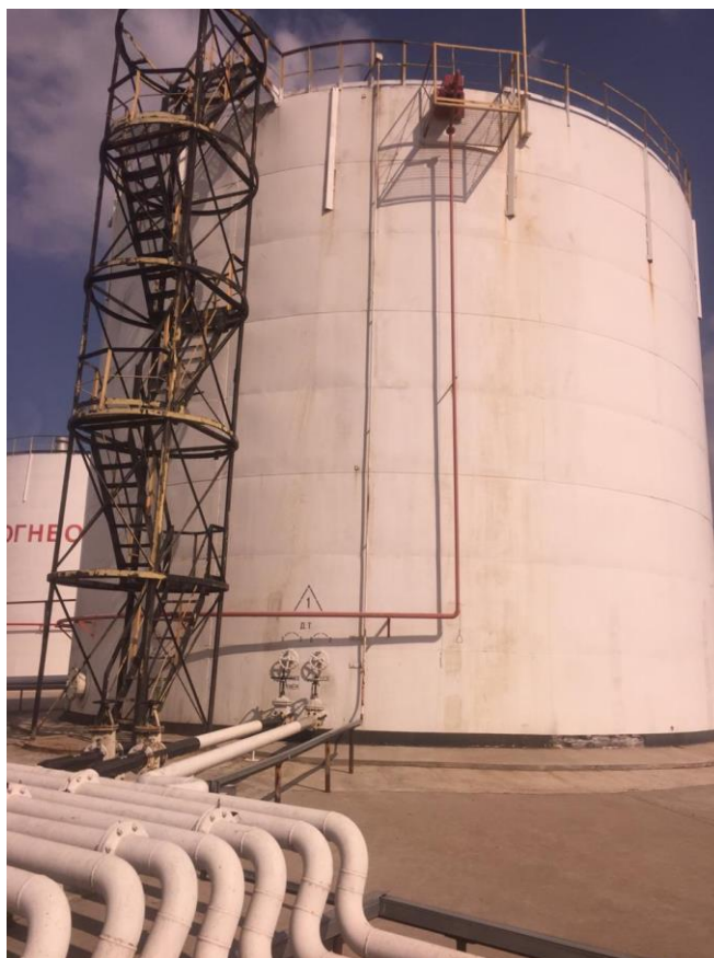
Рисунок 1 – Общий вид резервуара стального вертикального цилиндрического РВС-2000
