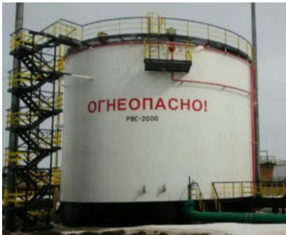
Рисунок 1 – Общий вид резервуара стального вертикального цилиндрического РВС-2000
