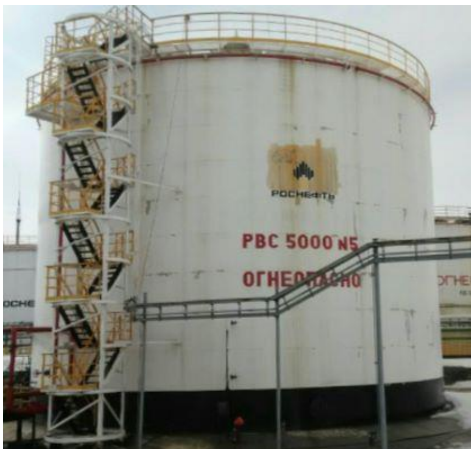
Рисунок 3 – Общий вид резервуаров стальных вертикальных цилиндрических РВС-5000
