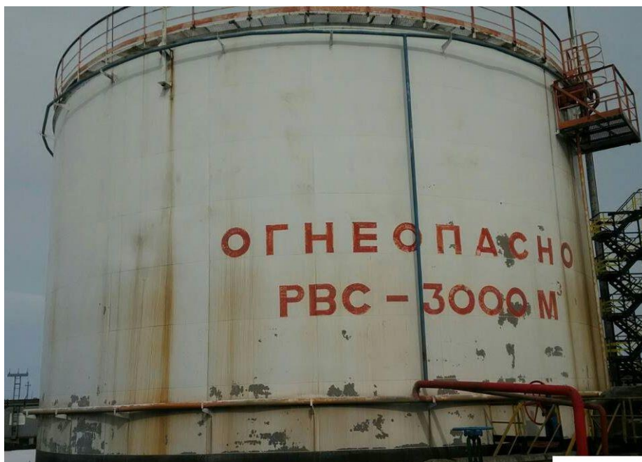
Рисунок 2 – Общий вид резервуара стального вертикального цилиндрического РВС-3000
