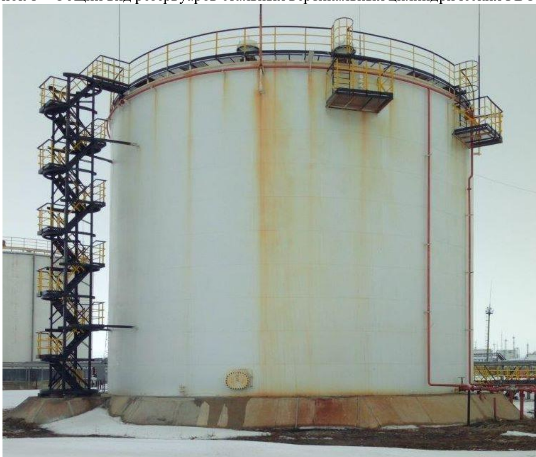
Рисунок 2 – Общий вид резервуаров стальных вертикальных цилиндрических РВС-5000
