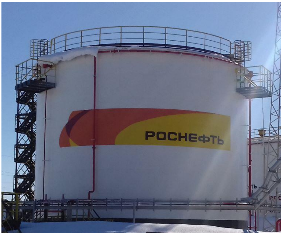
Рисунок 1 – Общий вид резервуаров стальных вертикальных цилиндрических РВС-2000
