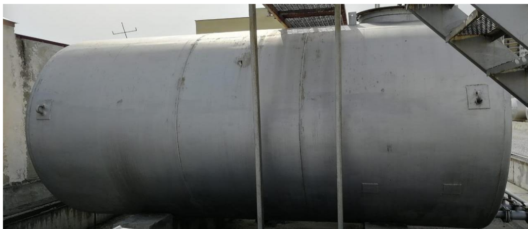
Рисунок 1 – Общий вид резервуара стального горизонтального цилиндрического РГС-25
