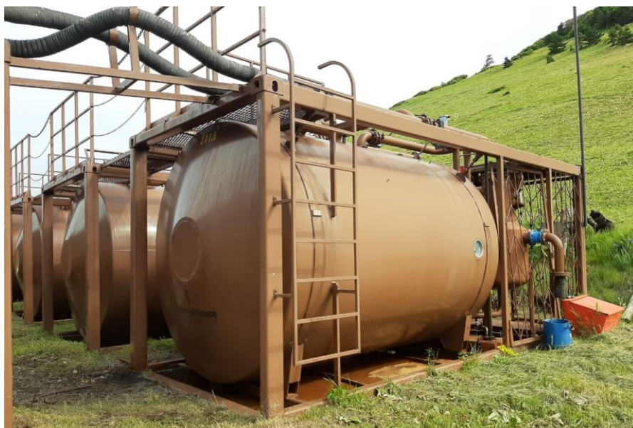
Рисунок 1 – Общий вид резервуаров Рк-15
