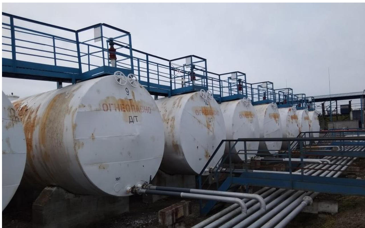
Рисунок 1 – Общий вид резервуаров РГС-75
