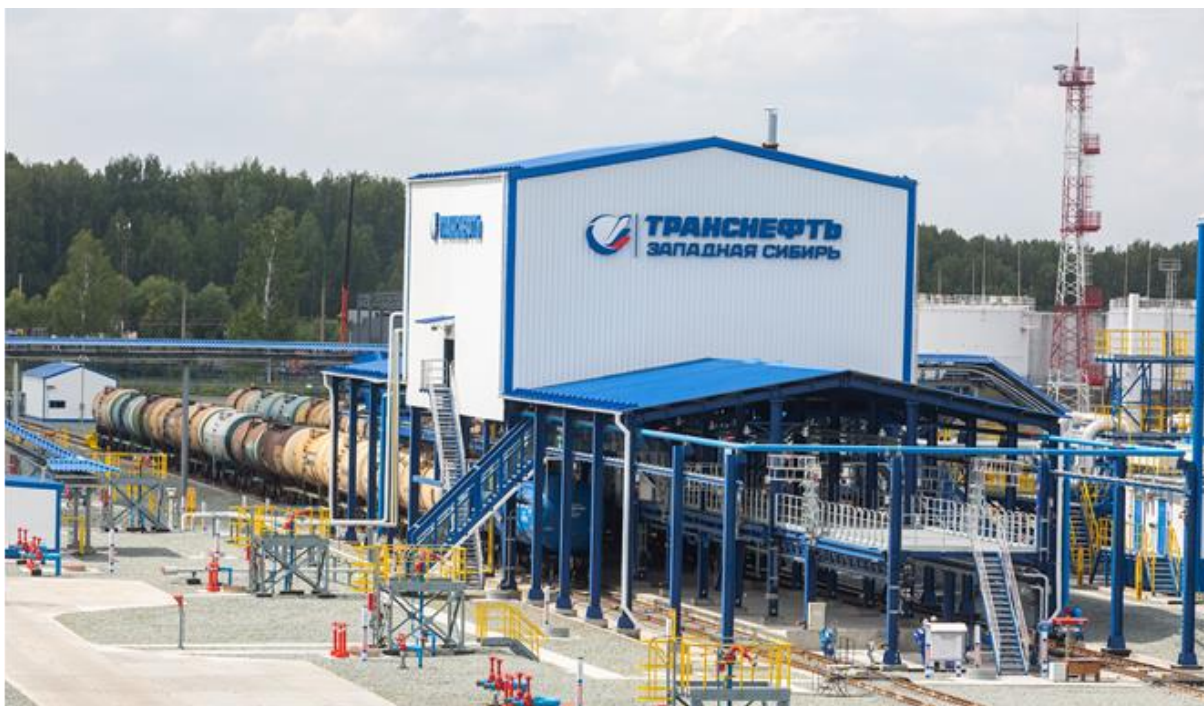
Рисунок 1 – Общий вид системы измерений количества нефтепродуктов АУТН ЛПДС «Сокур»
