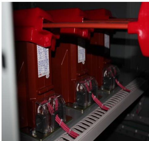
Рисунок 1 – Общий вид трансформаторов тока 2WD-122R
