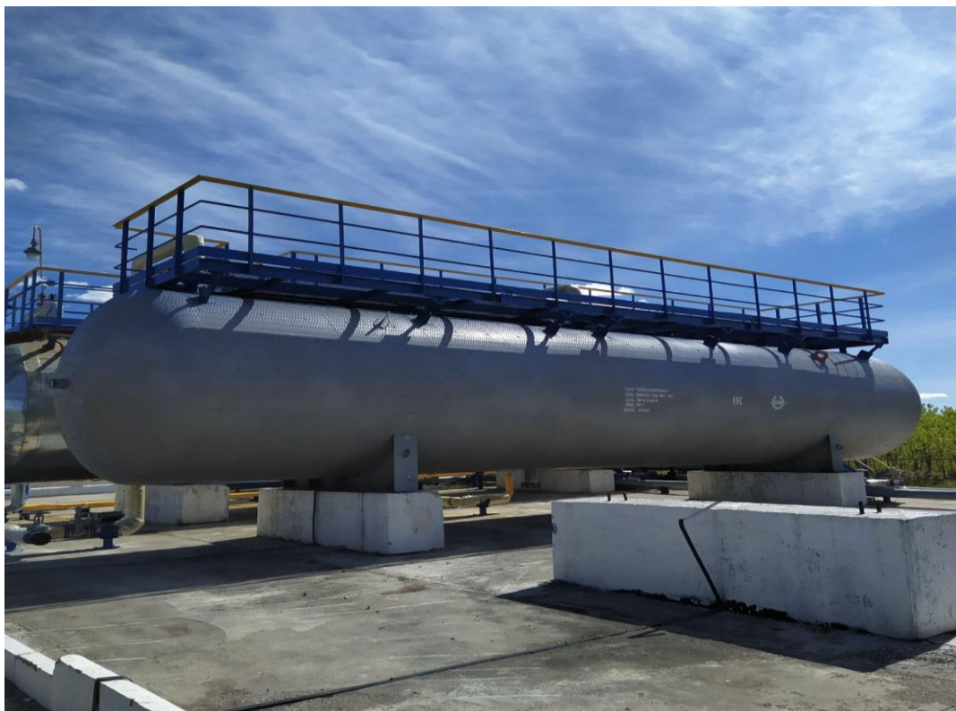
Рисунок 1 – Общий вид резервуара стального горизонтального цилиндрического РГС-100 Пломбирование резервуара стального горизонтального цилиндрического РГС-100 не предусмотрено.
