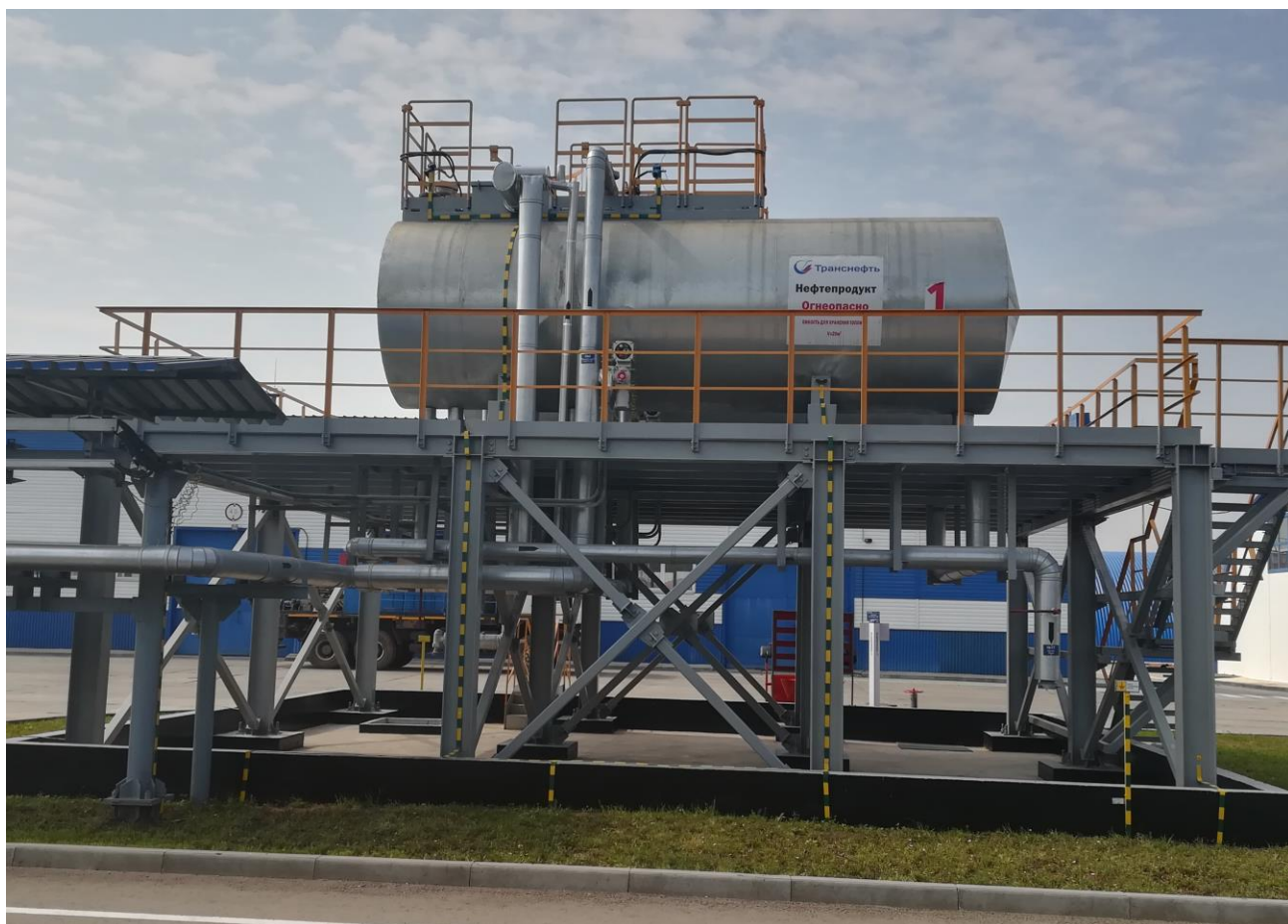
Рисунок 1 – Общий вид резервуаров РГС-20
