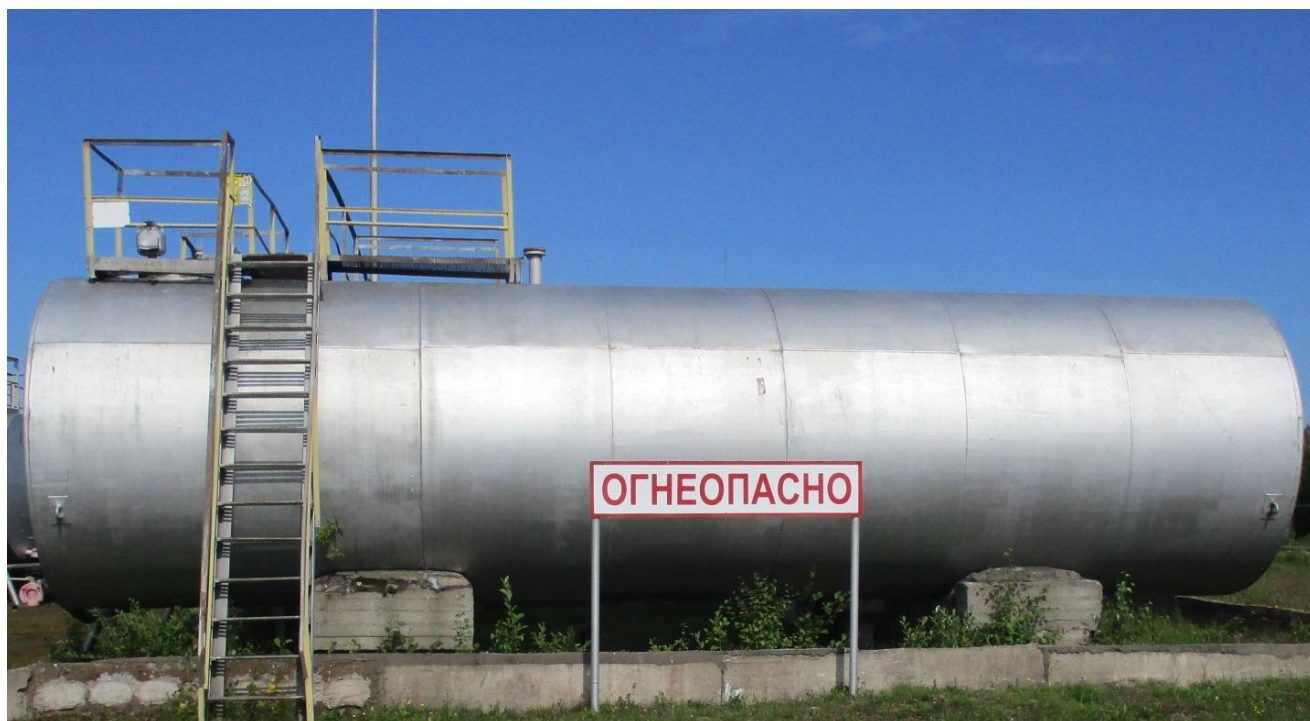
Рисунок 1 – Общий вид резервуара стального горизонтального цилиндрического РГС-60
