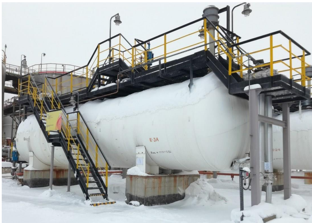
Рисунок 1 – Общий вид резервуара стального горизонтального цилиндрического РГС-100
