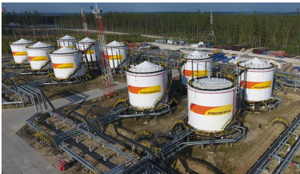
Рисунок 1 – Общий вид резервуаров стальных вертикальных цилиндрических РВС-700
