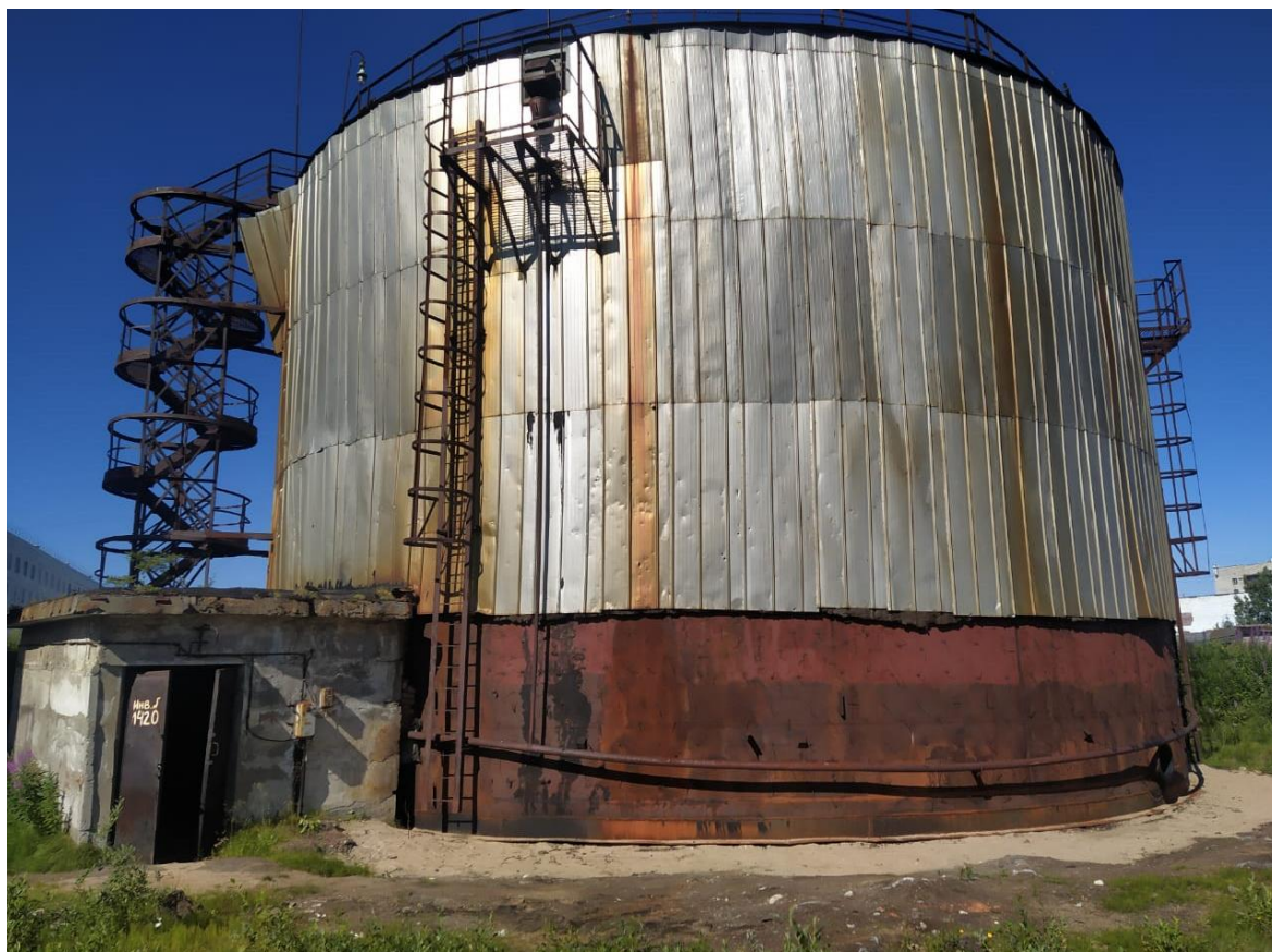
Рисунок 1 – Общий вид резервуара РВС-3000
