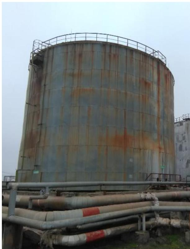
Рисунок 1 - Общий вид резервуара стального вертикального цилиндрического РВС-5000 зав. № 16 (по технологической схеме)
