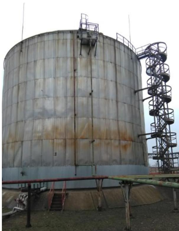
Рисунок 2 - Общий вид резервуара стального вертикального цилиндрического РВС-5000 зав. № 19 (по технологической схеме)
