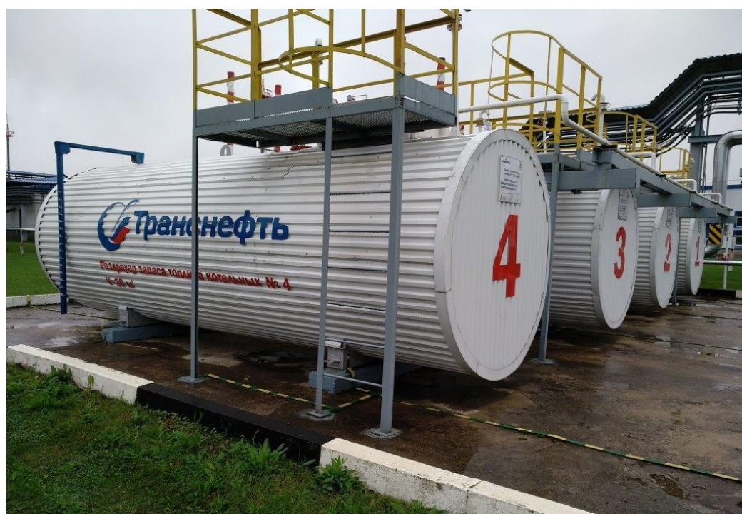
Рисунок 3 – Общий вид резервуаров РГС-20 ЛПДС «Невская»
