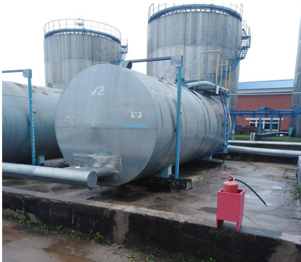
Рисунок 1 – Общий вид резервуаров РГС-20 ЛПДС «Кириши»
