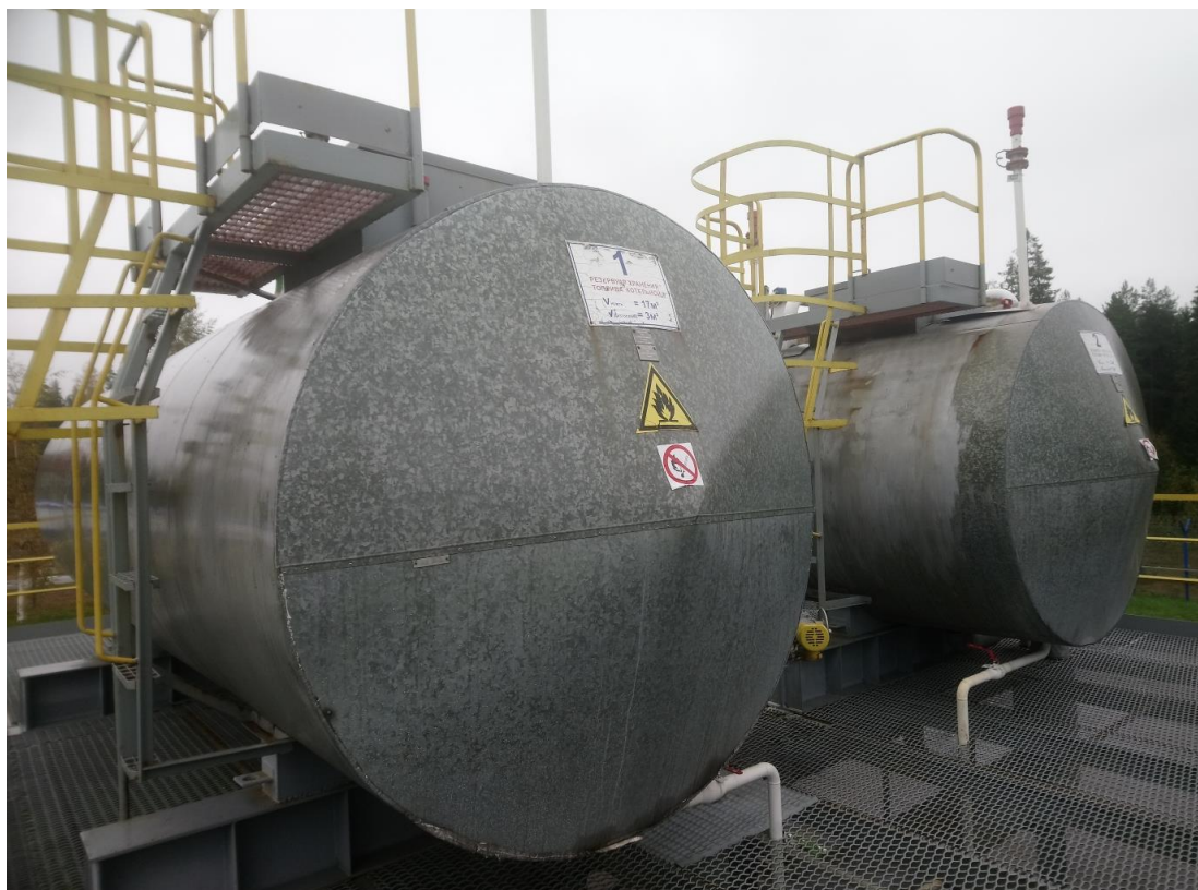
Рисунок 6 – Общий вид резервуаров РГС-20 НПС «Сестрорецкая»
