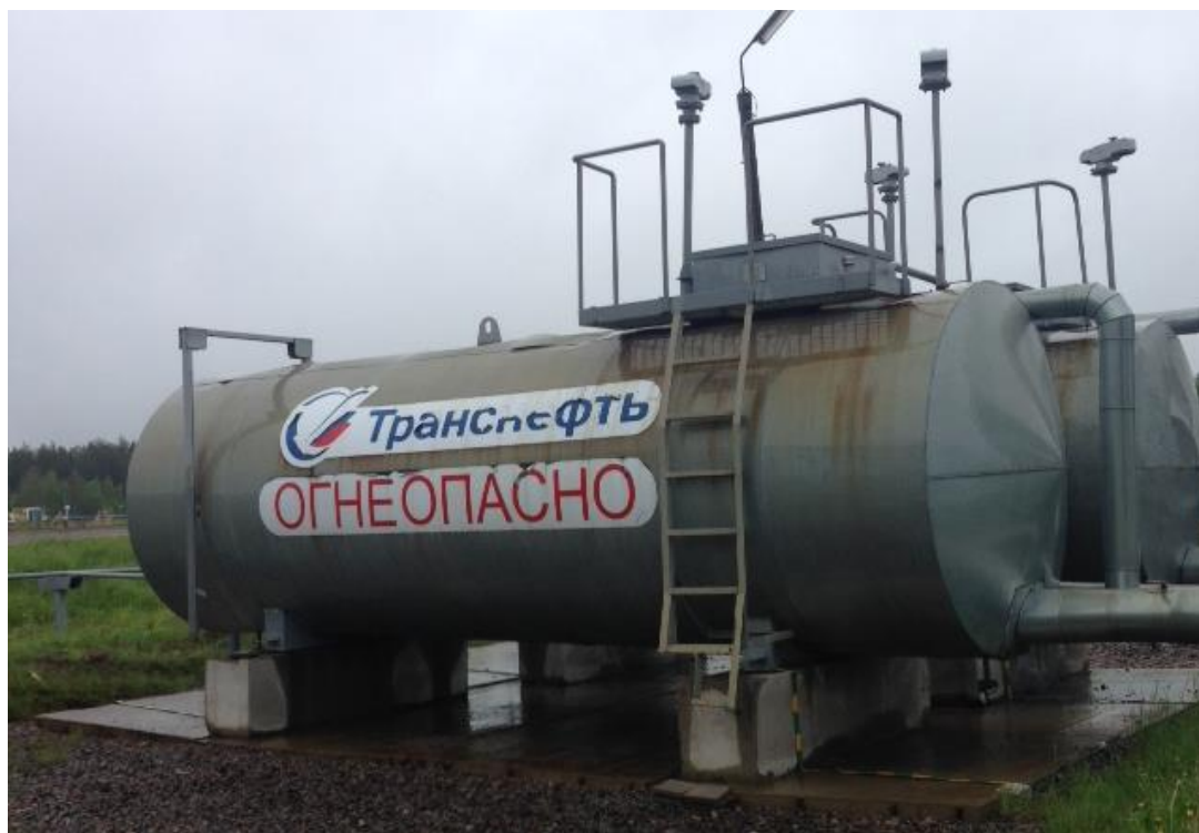
Рисунок 2 – Общий вид резервуаров РГС-20 ЛПДС «Красный Бор»
