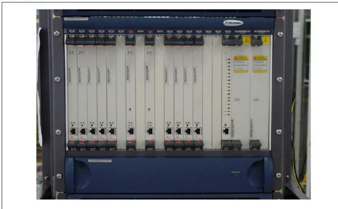
Рисунок 1 - Общий вид системы измерений длительности соединений СИДС CSC3300
