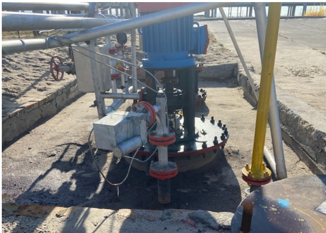
Рисунок 1 – Общий вид резервуара РГС-12,5 № 335
