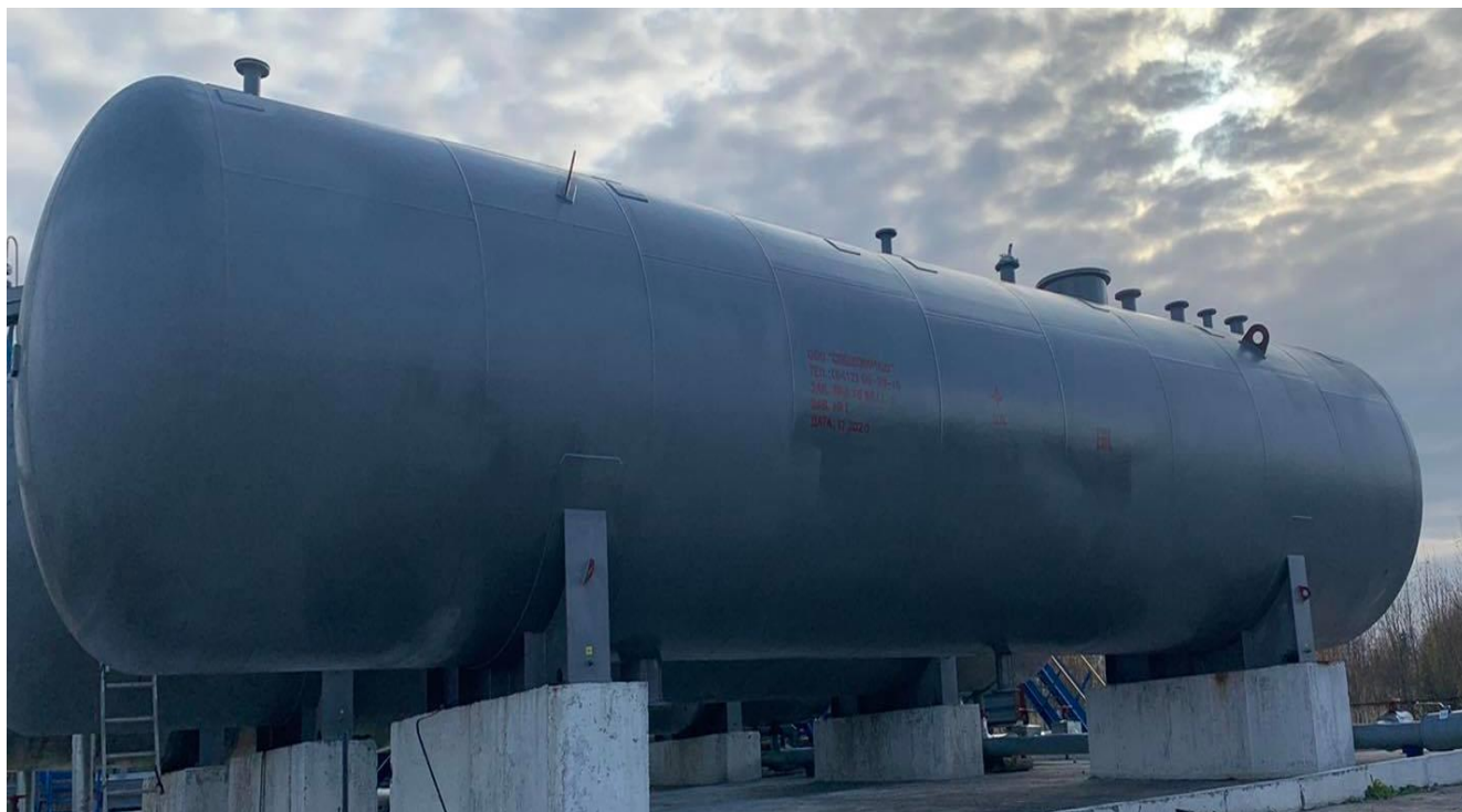
Рисунок 1 – Общий вид резервуара стального горизонтального цилиндрического РГС-100
