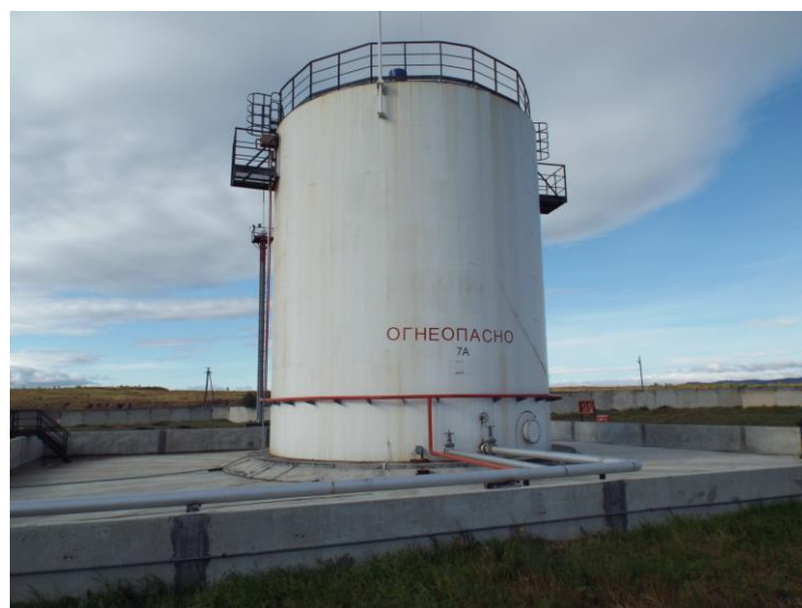
Рисунок 1 – Общий вид резервуара РВС – 1000 № 7а
