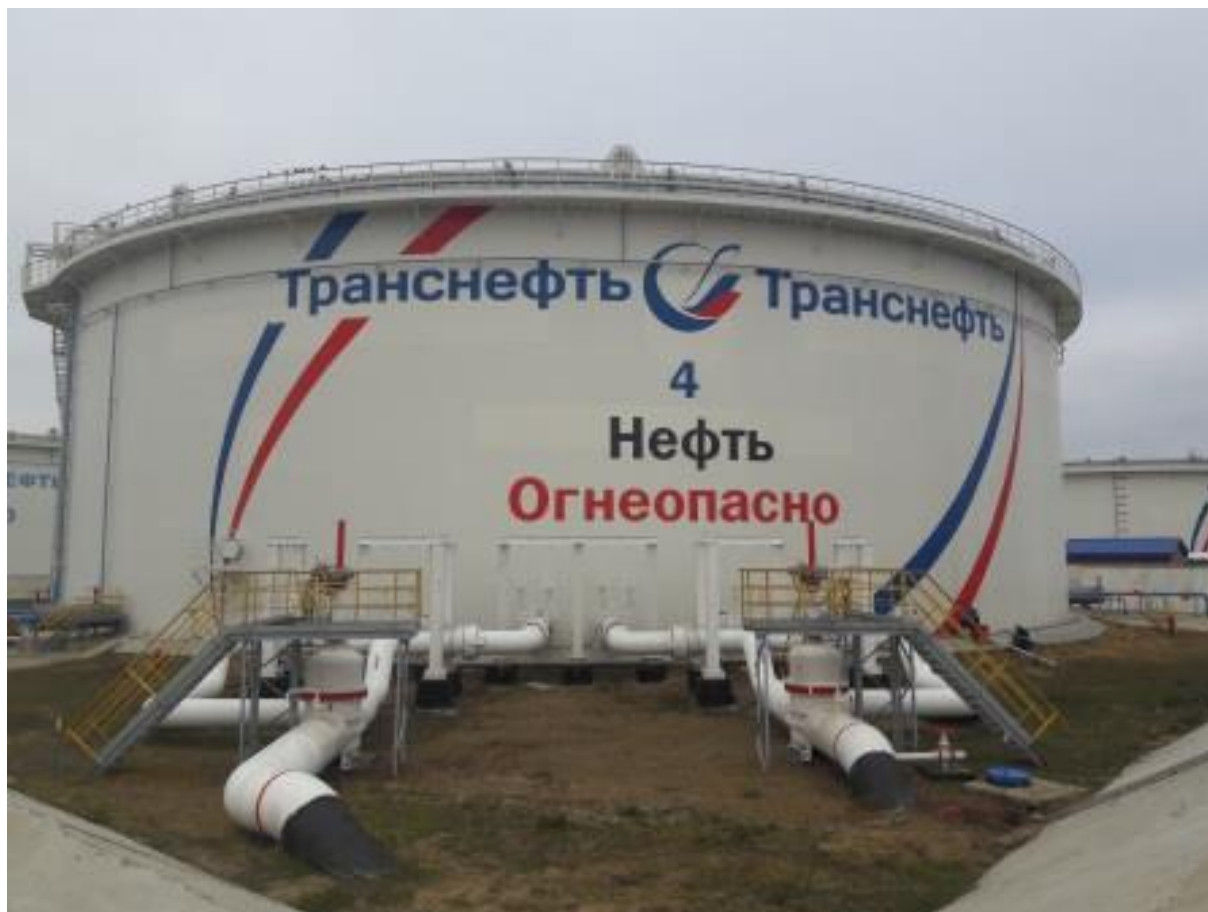
Рисунок 1 – Общий вид резервуара РВСПК-50000
