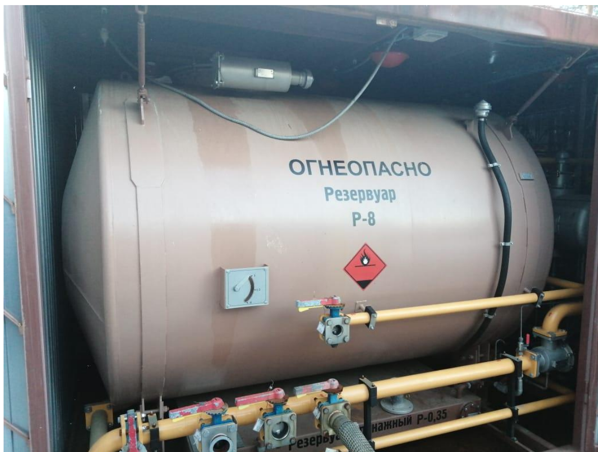
Рисунок 1 – Общий вид резервуаров Р-8
