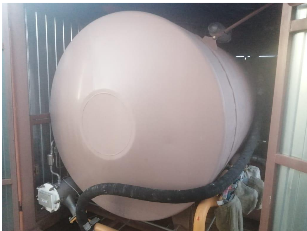
Рисунок 2 – Общий вид резервуаров Р-17
