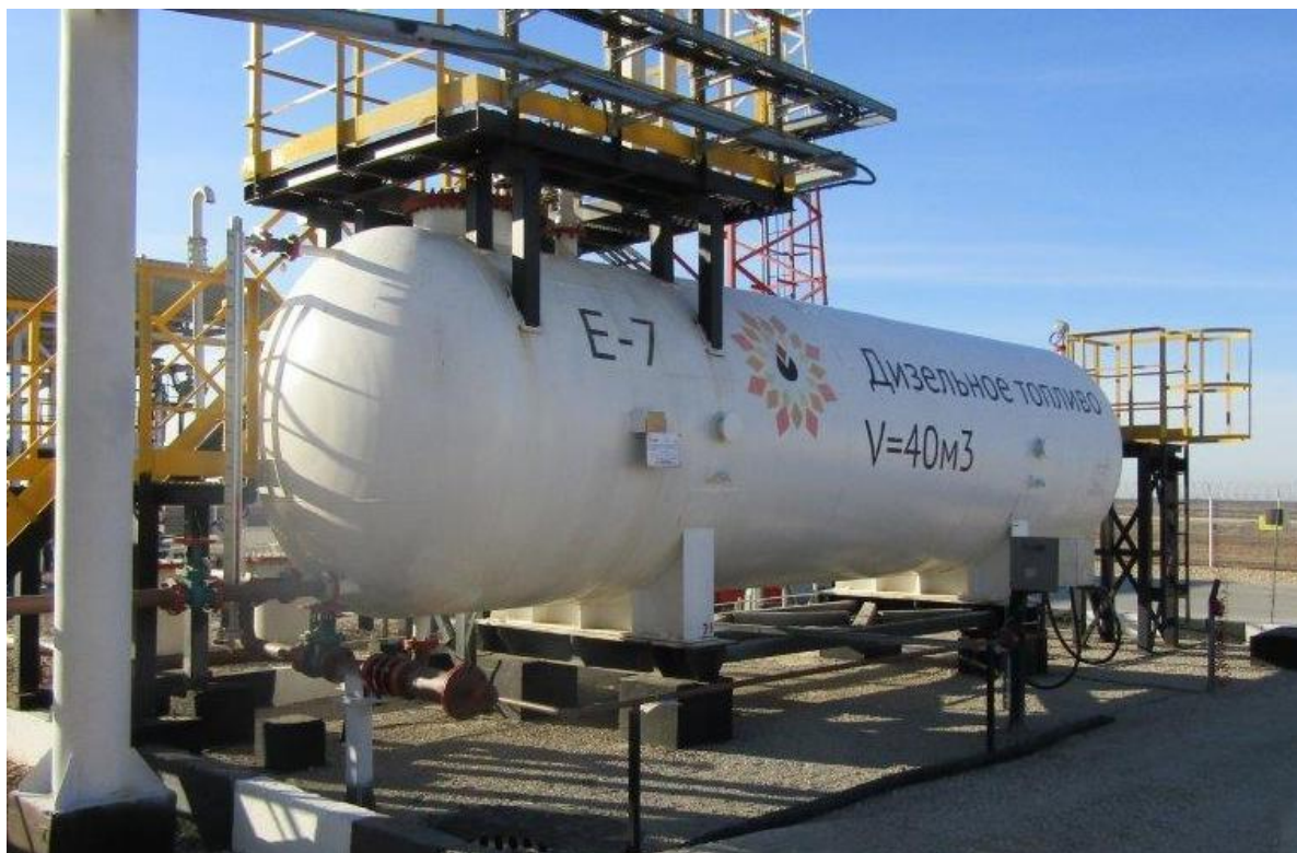
Рисунок 1 – Резервуар горизонтальный стальной цилиндрический РГС-40
