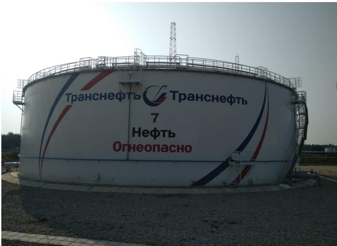
Рисунок 1 – Общий вид резервуаров РВСП-20000
