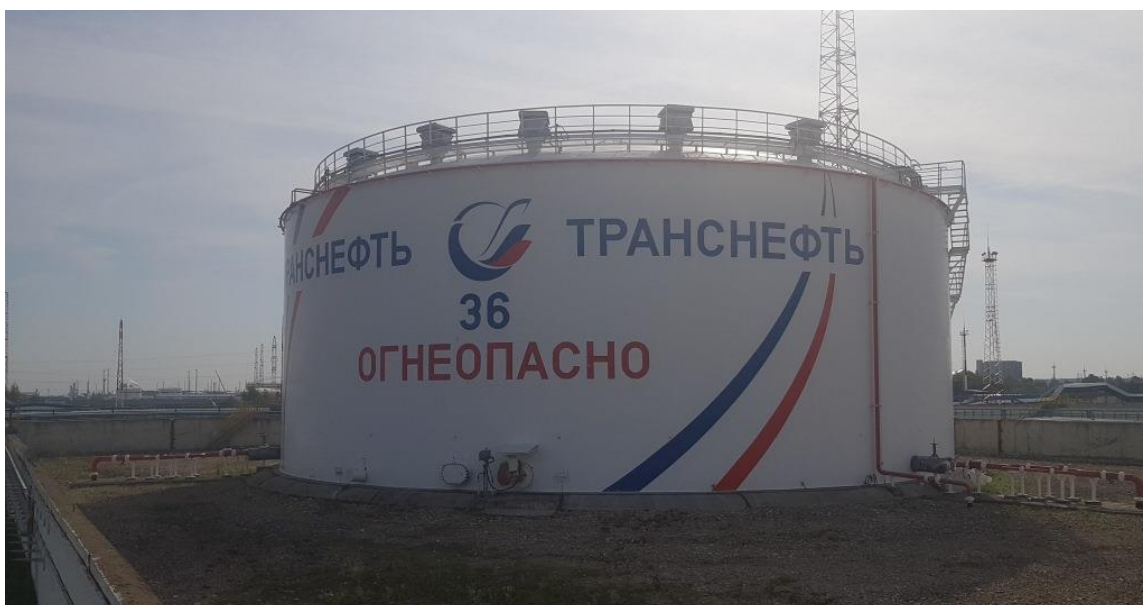
Рисунок 1 – Общий вид резервуара РВС-10000
