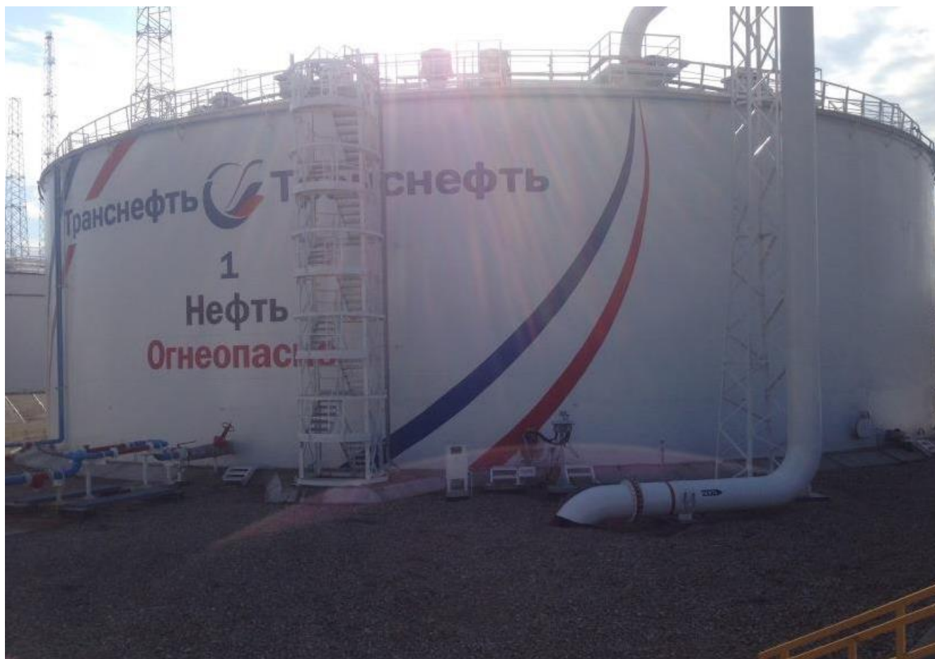
Рисунок 2 – Общий вид резервуара РВС-20000
