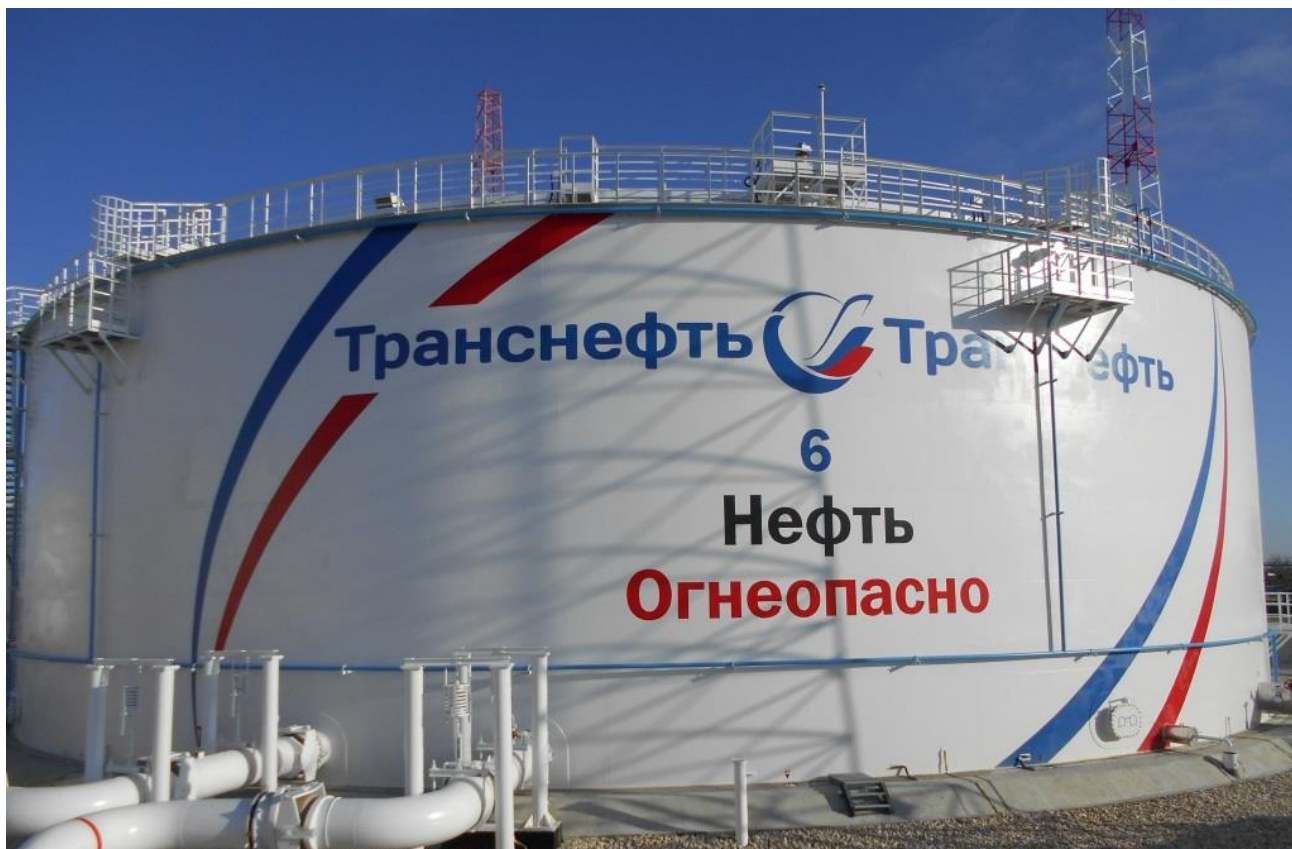
Рисунок 1 – Общий вид резервуаров РВСП-20000
