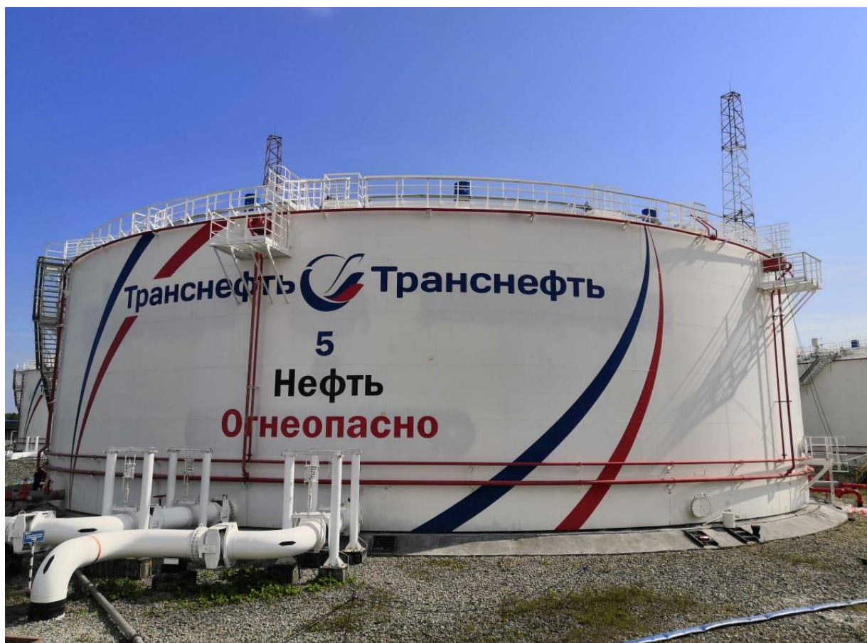
Рисунок 1 – Общий вид резервуаров РВСП-20000
