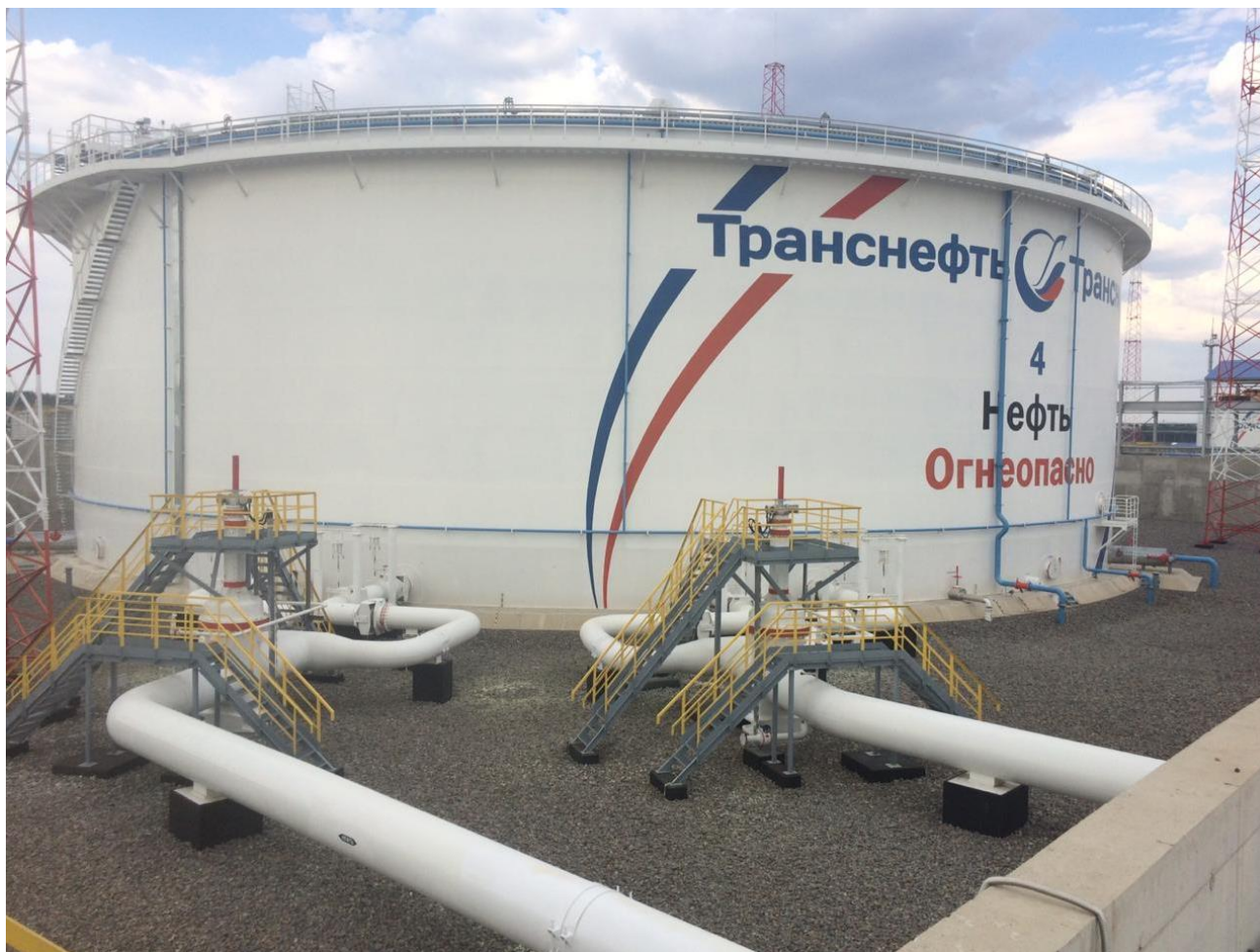
Рисунок 1 – Общий вид резервуаров РВСПК-50000
