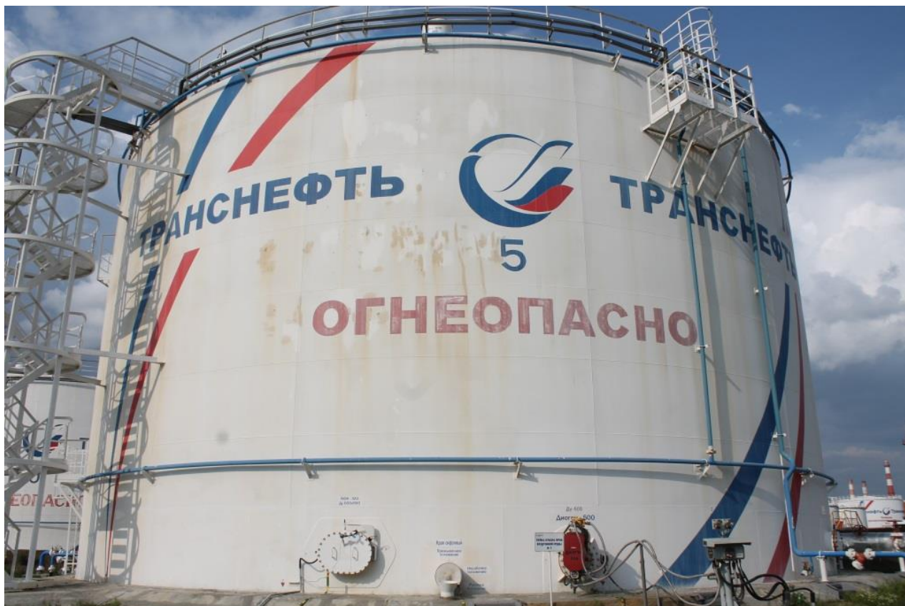
Рисунок 1 – Общий вид резервуара РВСП-5000
