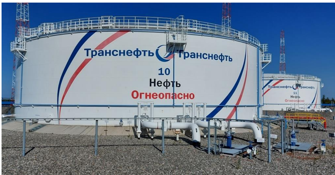
Рисунок 1 – Общий вид резервуаров РВСП-20000
