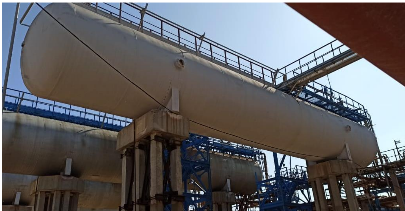
Рисунок 1 – Общий вид резервуаров РГС-200 зав.№ 39229, 39231, 45134, 45135, 45136, 45185
