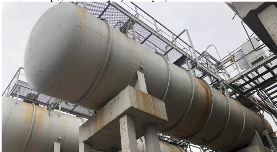
Рисунок 1 – Общий вид резервуаров РГС-100 зав.№ 39848, 39849, 39957, 45015, 45017, 45029, 45030, 45031, 45032, 45033, 45045, 45046, 45061, 45074, 45082, 45083, 45108, 45109, 45110, 45111
