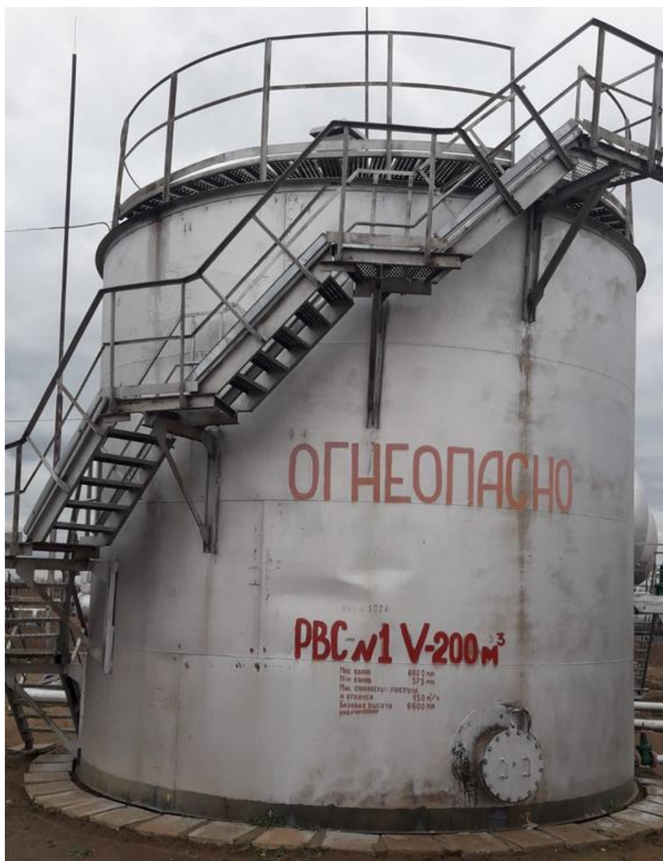
Рисунок 1 – Общий вид резервуара стального вертикального цилиндрического РВС-200
