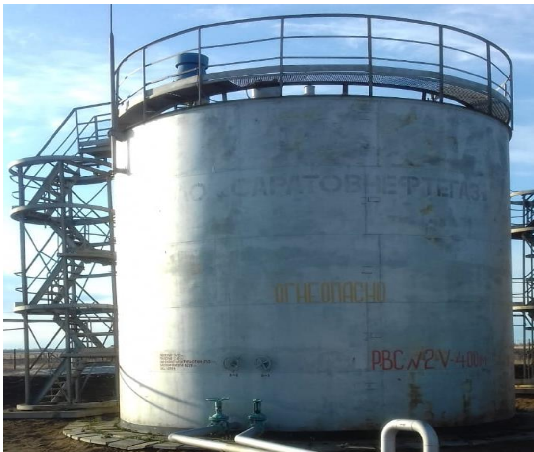
Рисунок 2 – Общий вид резервуара стального вертикального цилиндрического РВС-400
