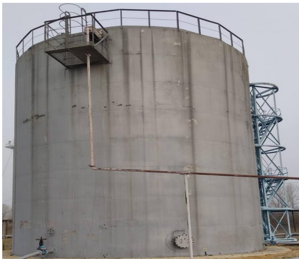
Рисунок 3 – Общий вид резервуара стального вертикального цилиндрического РВС-1000
