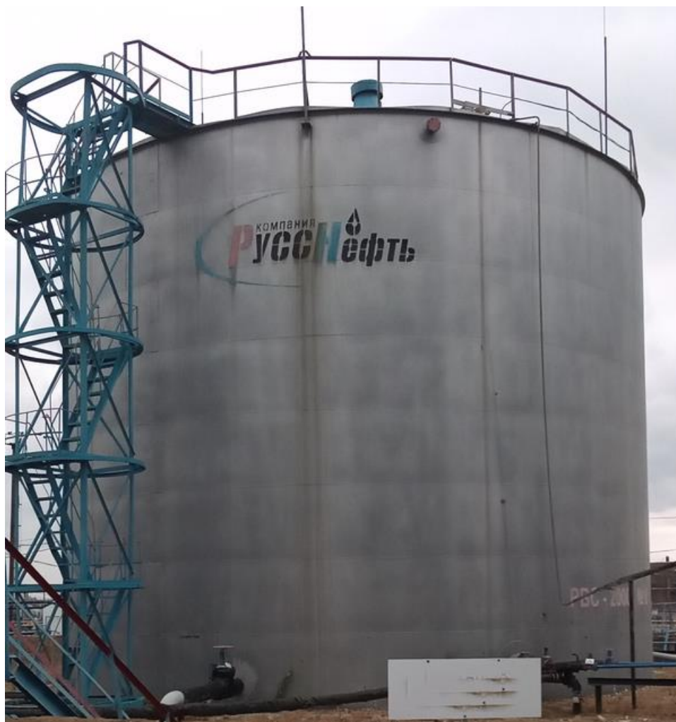
Рисунок 4 – Общий вид резервуара стального вертикального цилиндрического РВС-2000
