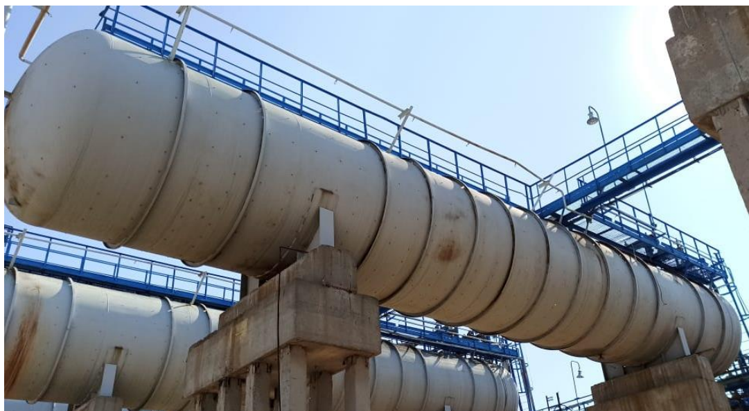
Рисунок 1 – Общий вид резервуаров РГС-200 зав.№ 315, 725, 926
