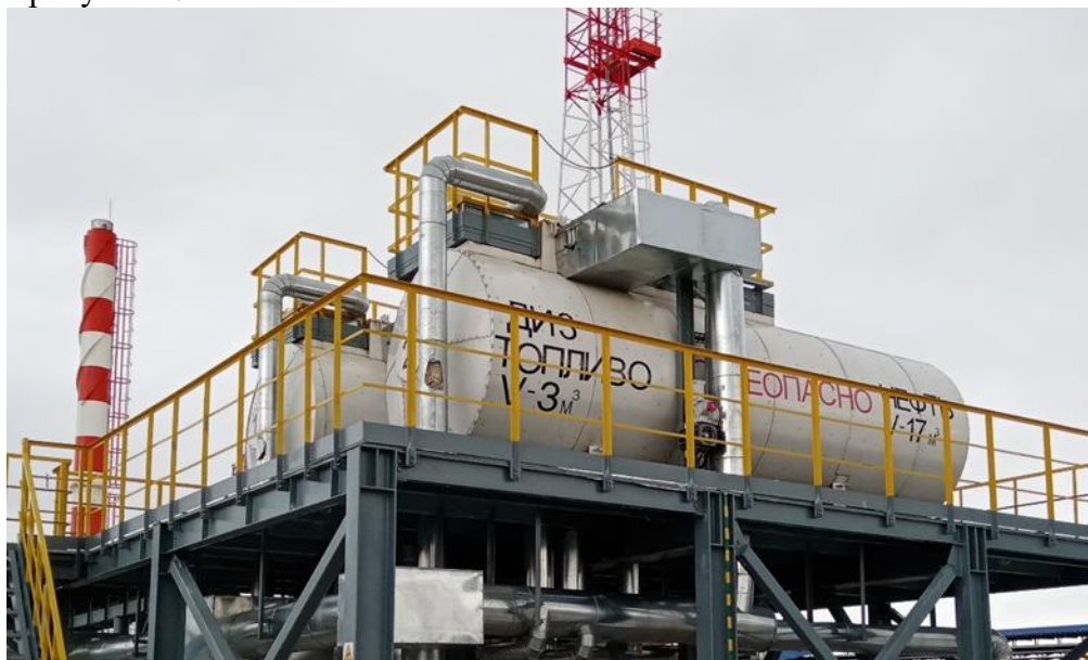
Рисунок 1 – Общий вид резервуаров РГС-20
