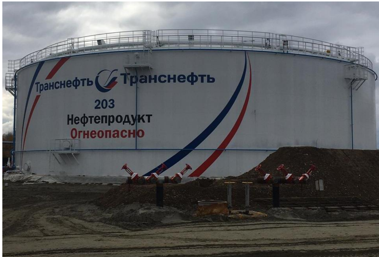
Рисунок 2 – Общий вид резервуаров РВСП-20000
