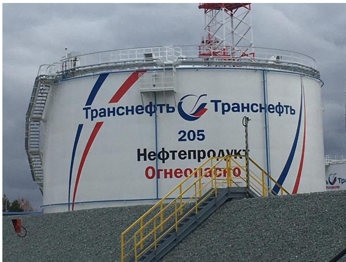
Рисунок 1 – Общий вид резервуаров РВСП-5000
