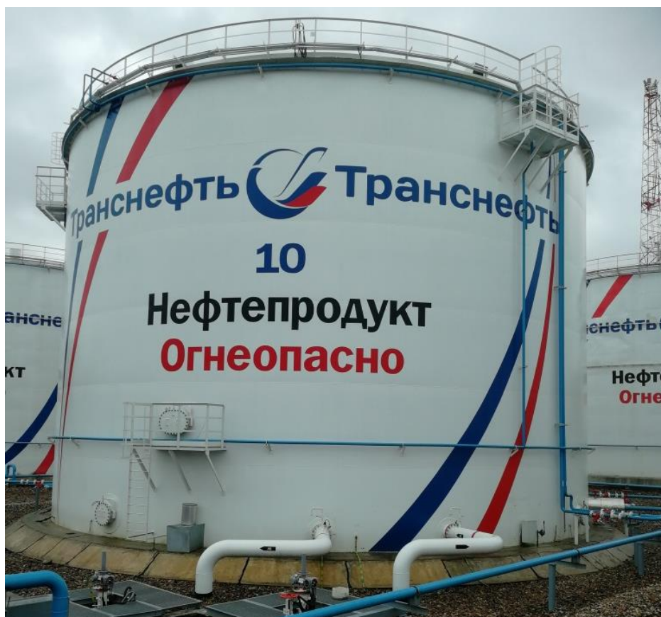
Рисунок 2 – Общий вид резервуара РВСП-5000
