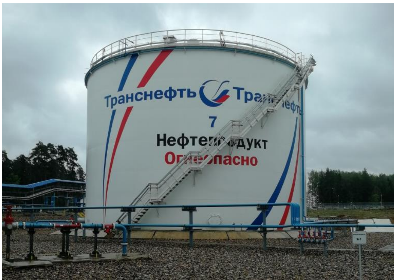
Рисунок 1 – Общий вид резервуаров РВС-5000
