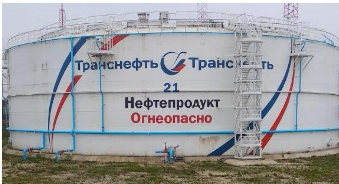
Рисунок 4 – Общий вид резервуара РВС-20000
