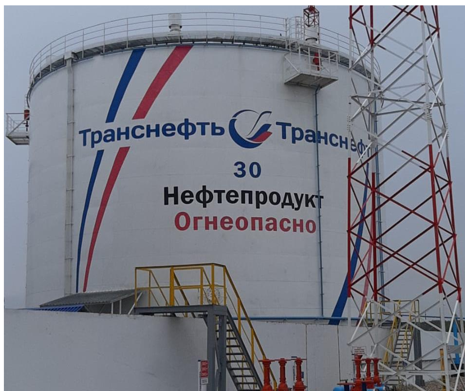
Рисунок 3 – Общий вид резервуара РВСП-7500
