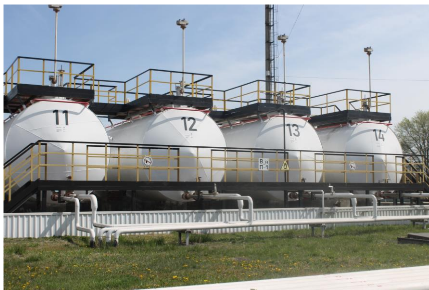
Рисунок 1 – Общий вид резервуаров стальных горизонтальных цилиндрических РГС-125
