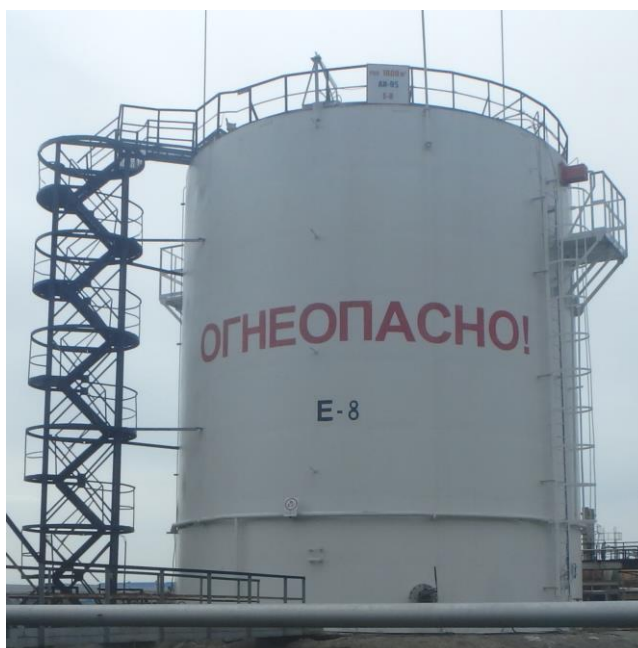
Рисунок 1 – Общий вид резервуаров стальных вертикальных цилиндрических РВС-1000
