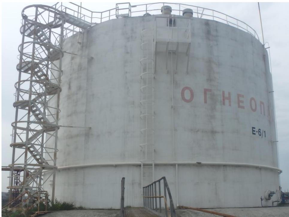
Рисунок 2 – Общий вид резервуаров стальных вертикальных цилиндрических РВС-3000
