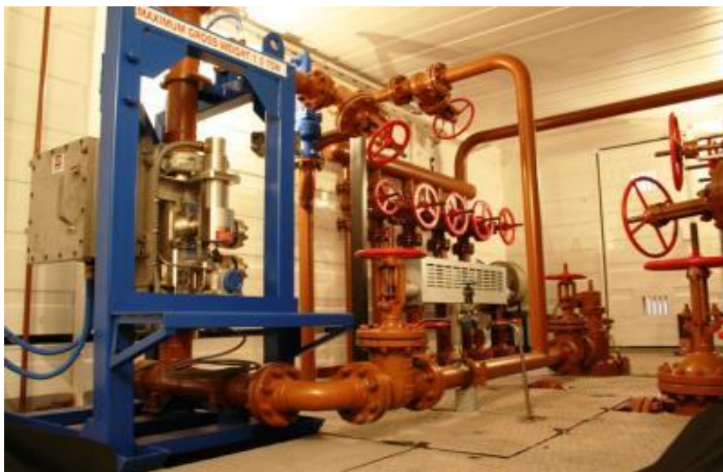
Фотография 1 - Общий вид
