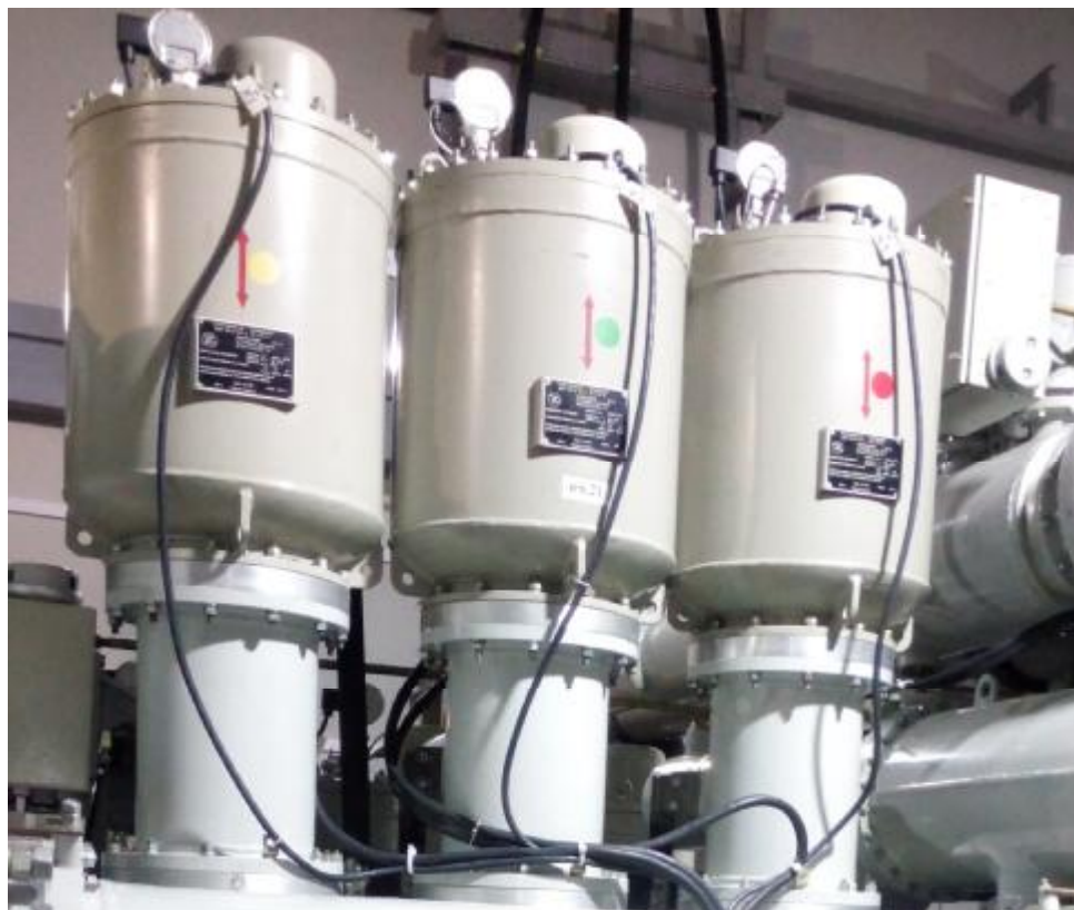
Рисунок 1 – Внешний вид трансформатора напряжения ЗНОГ-110 – IV УХЛ 4
