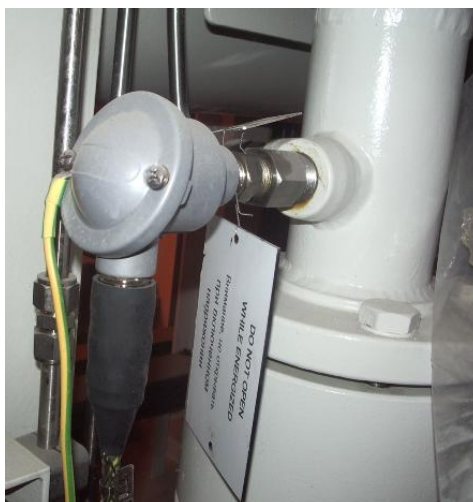
Рисунок 1 - Внешний вид преобразователя термоэлектрического с двумя термопарами
