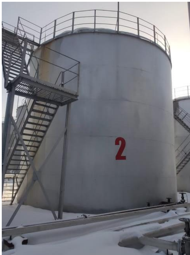
Рисунок 1 – Общий вид резервуаров РВС-400
