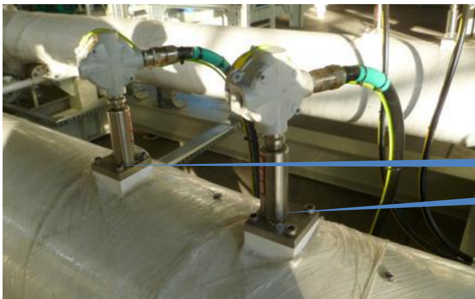
Рисунок 2 – Место нанесения заводской пломбы
