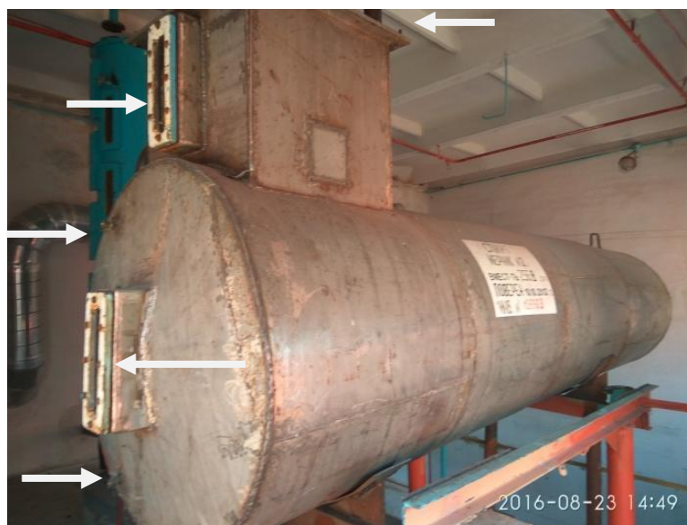
Рисунок 1 - Общий вид и места пломбирования мерника
