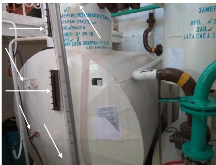
Рисунок 1 - Общий вид и места пломбирования мерника
