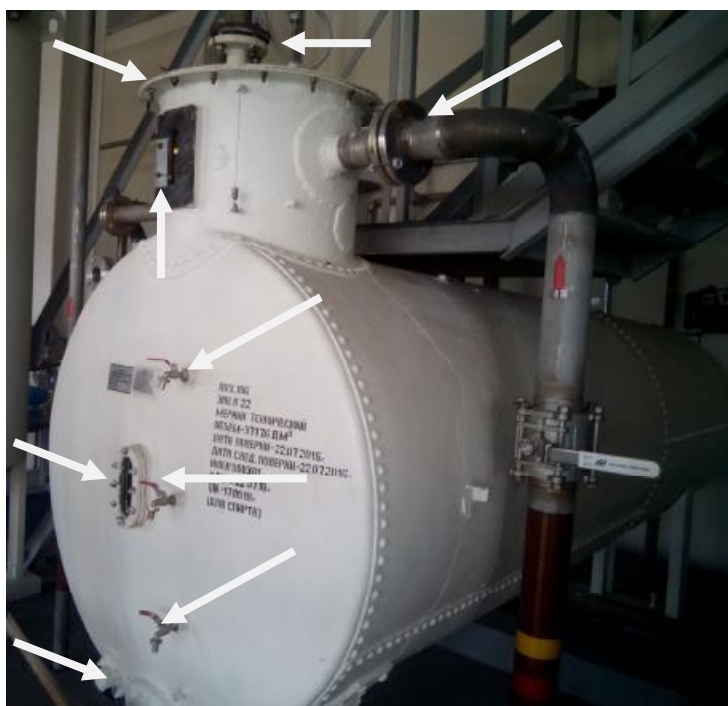
Рисунок 1 - Общий вид и места пломбирования мерника
