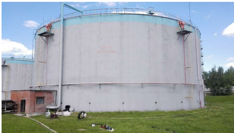
Рисунок 1 - Общий вид резервуара
